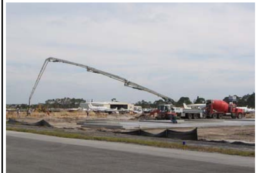
Concrete pour at the new T-hangars
